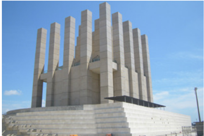
うみそらトンネル換気塔
