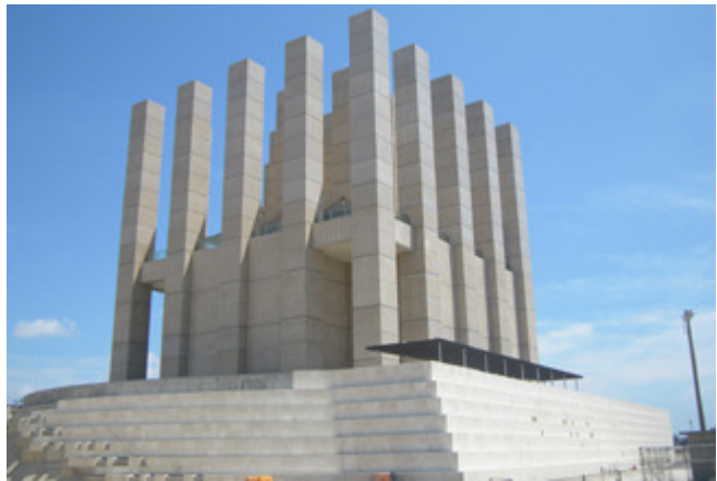
うみそらトンネル換気塔
