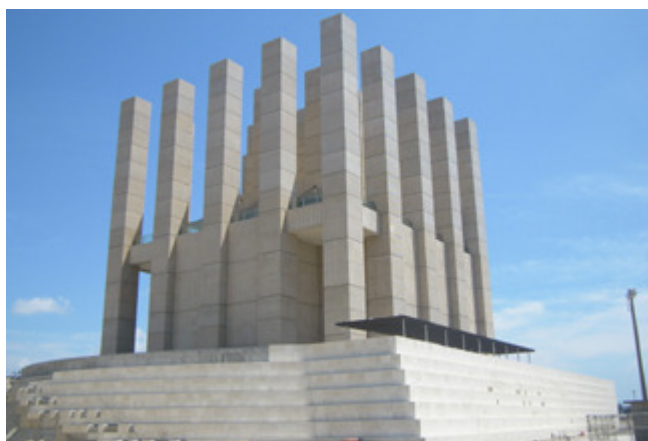
うみそらトンネル換気塔
