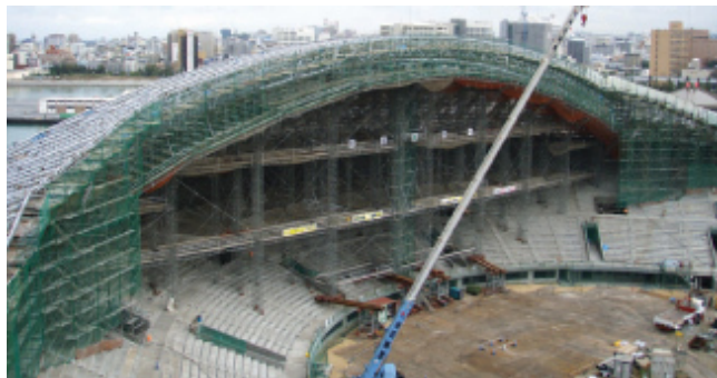
那覇市営奥武山野球場その他関連施設設備工事
