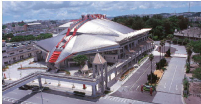
沖縄県立武道館アリーナ棟建設工事
